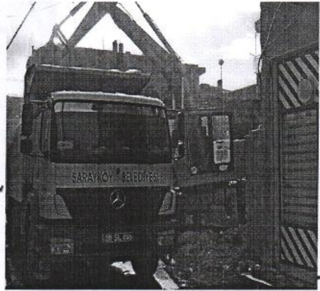
Bala Mahallesi Yıkım Çalışması
