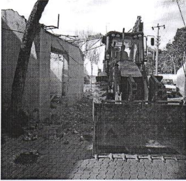
Turan Mah. Elektrik Geçidi Yıkım Çalışması
