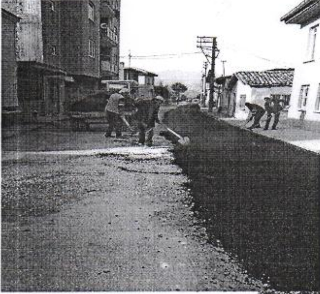
AŐađı Mah. Yol Bakım alıŐması
